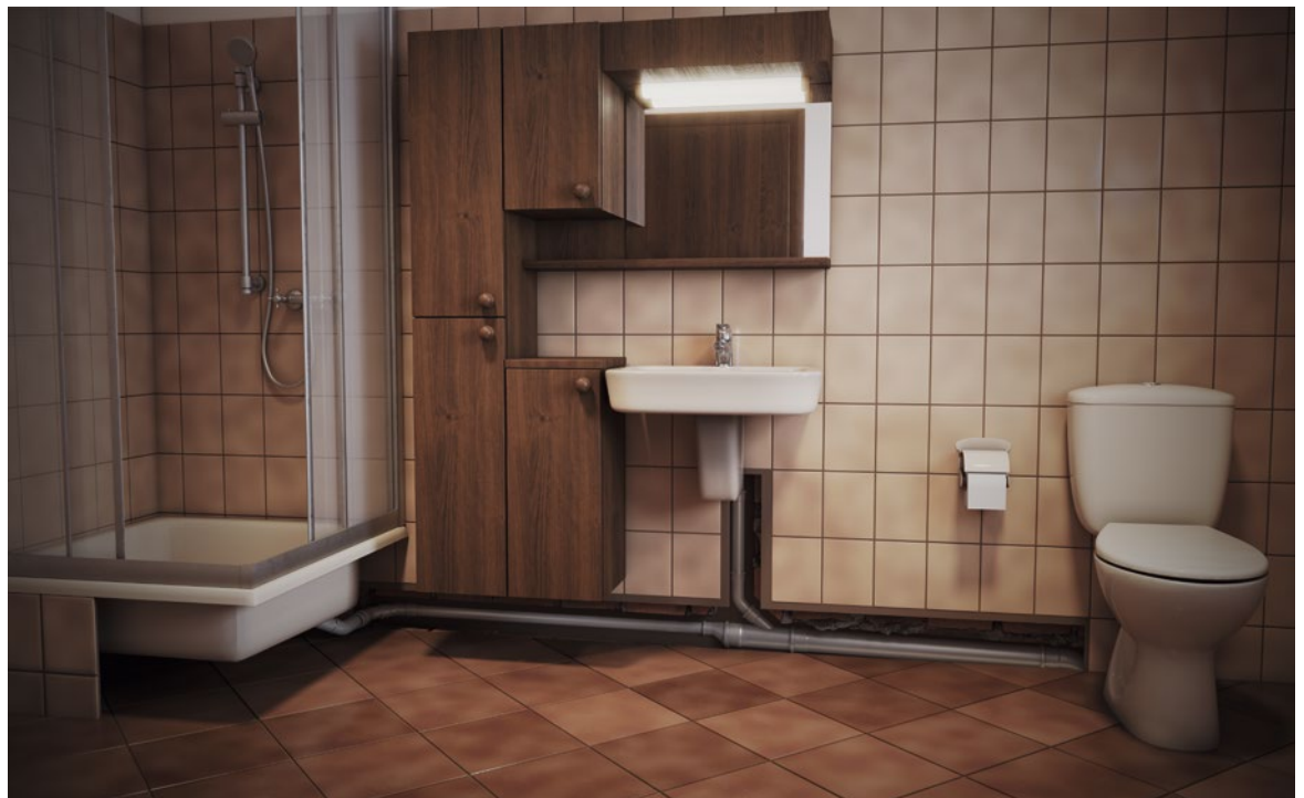
Das in die Jahre gekommene Bad mit erhöhter Duschwanne. Im Untergrund sichtbar gemacht der Verlauf der alten Abwasserleitung (grau).
